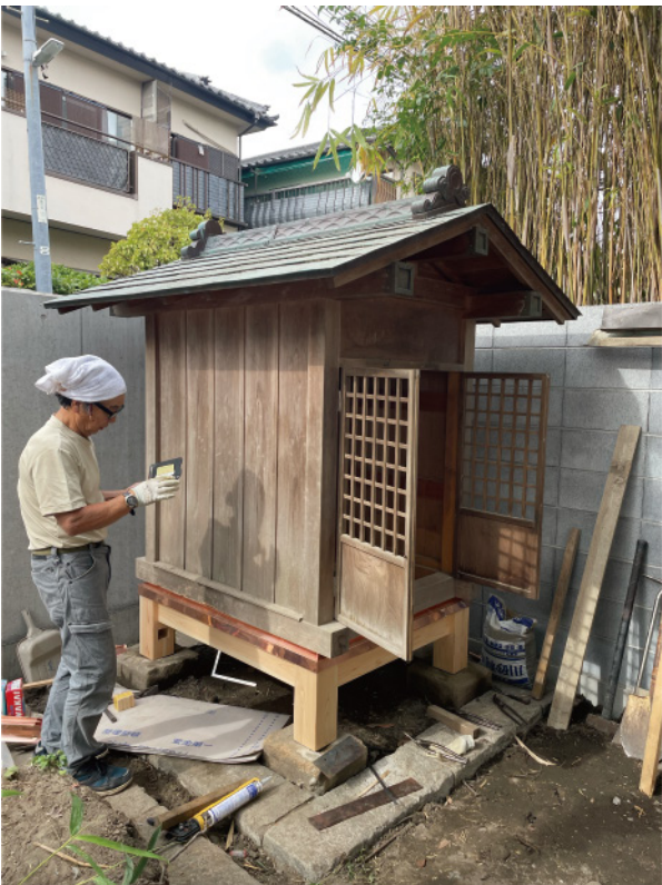
祠の移設 礎石基礎から石場建てに変更
