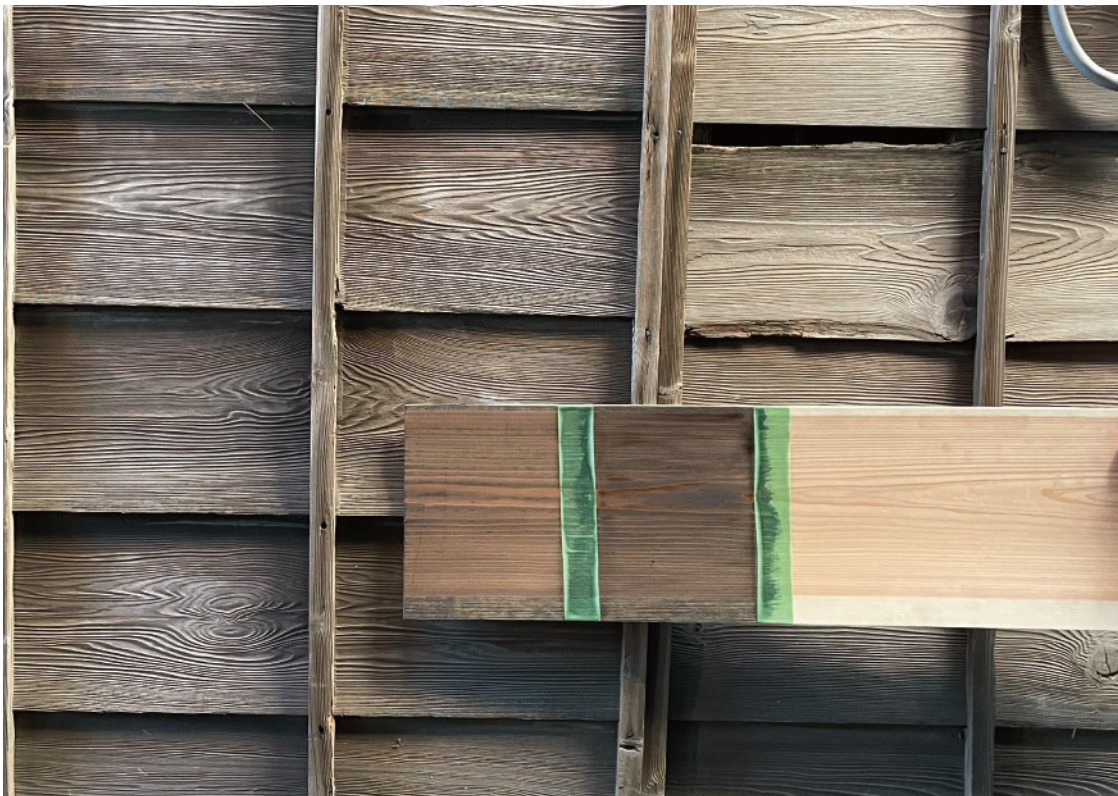
母屋外壁 復旧色の検討
