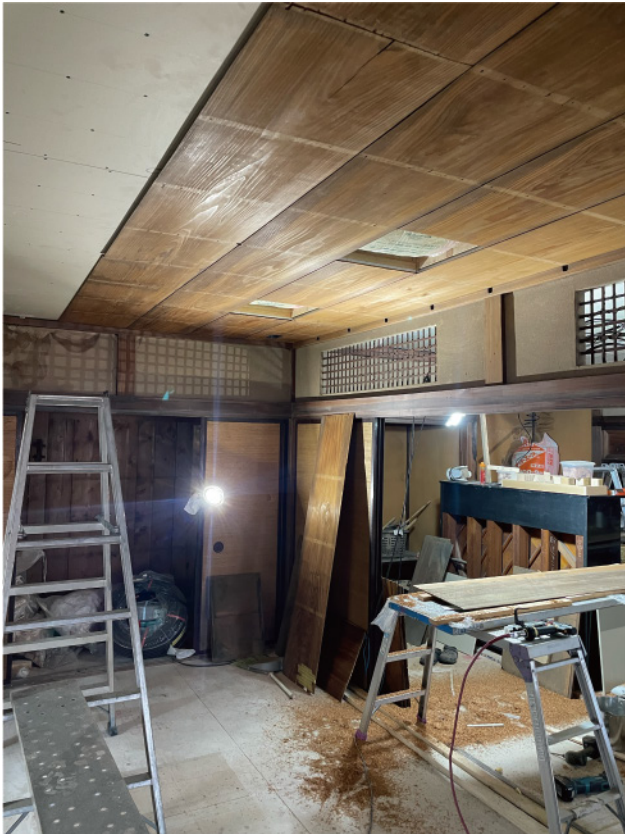
母屋 2F 天井復旧
