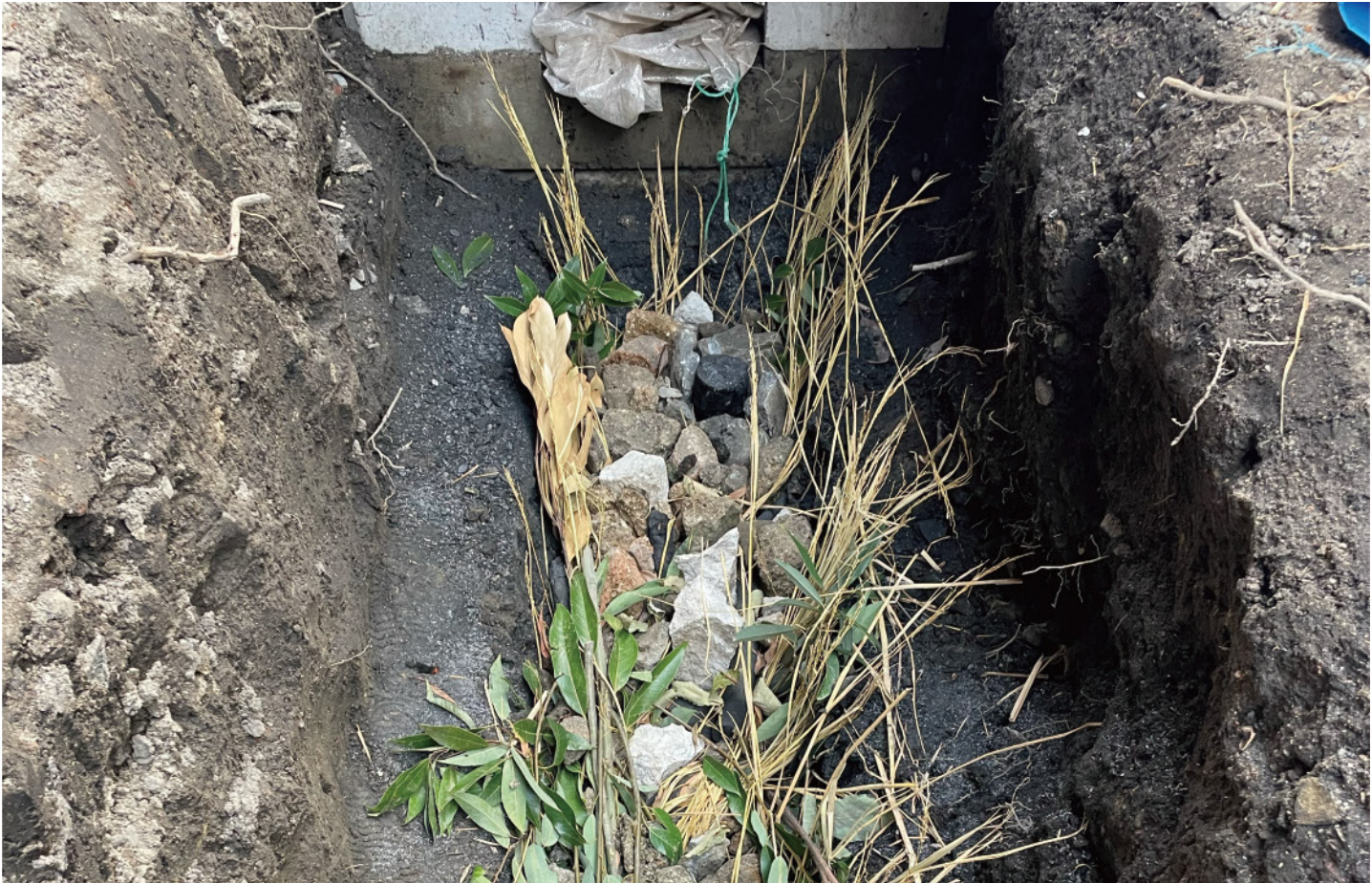
ぐり石、焼き杭、炭、くん炭、藁、枝葉による浸透溝
