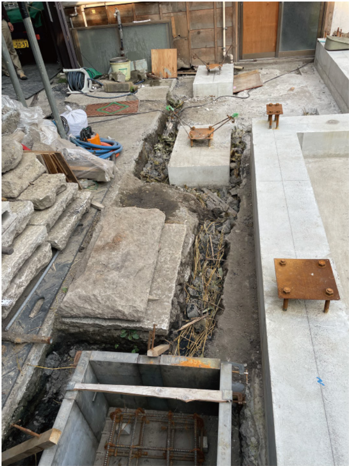
増築部の建物際への浸透溝
