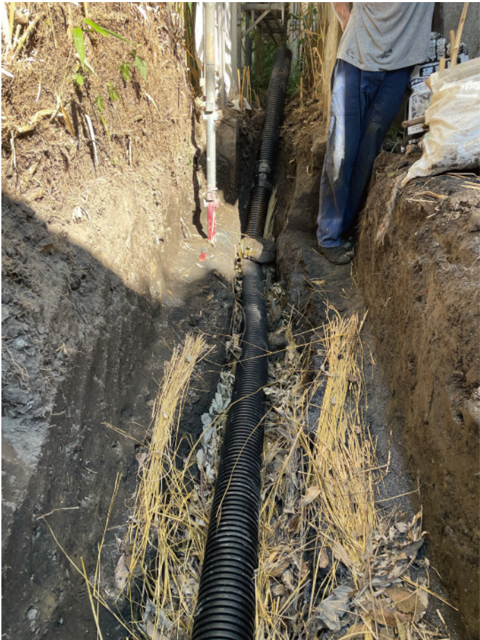
新設塀下部の浸透溝 コルゲート管による浸透通気
