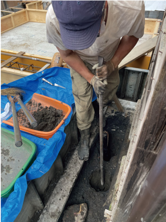
母屋と増築部の隙間への縦穴施工
