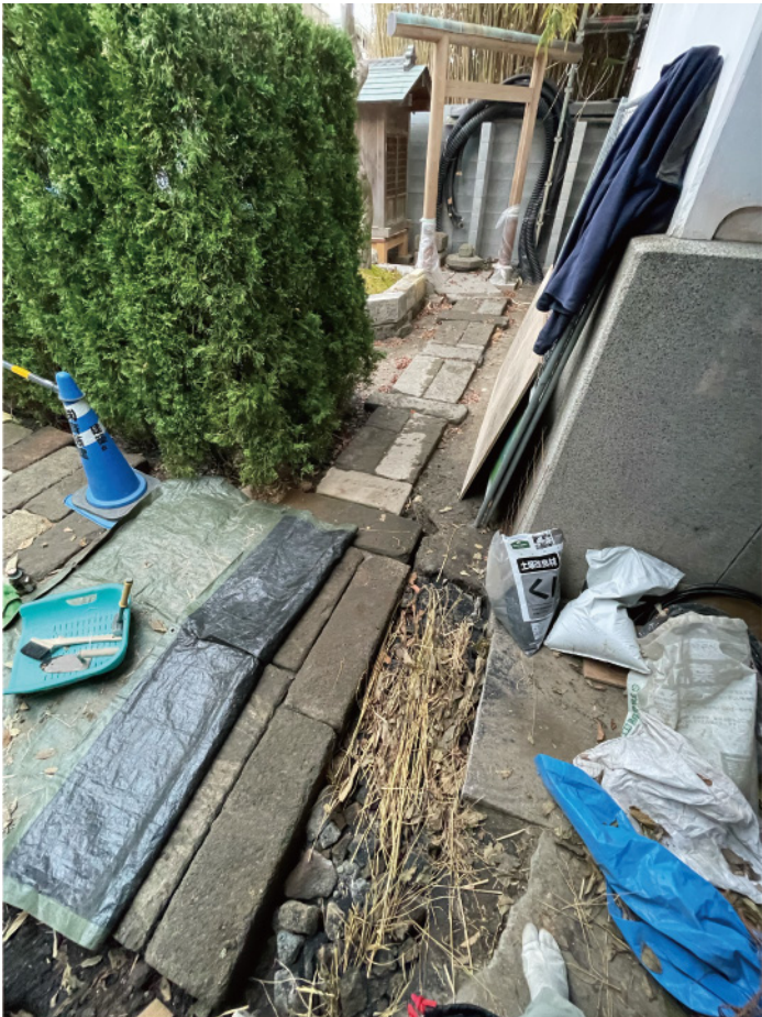
通路の水下側への浸透溝
