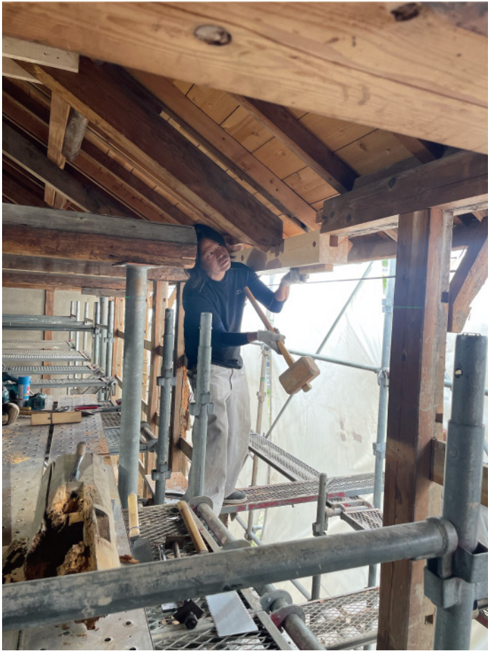
軒桁の入れ替え
