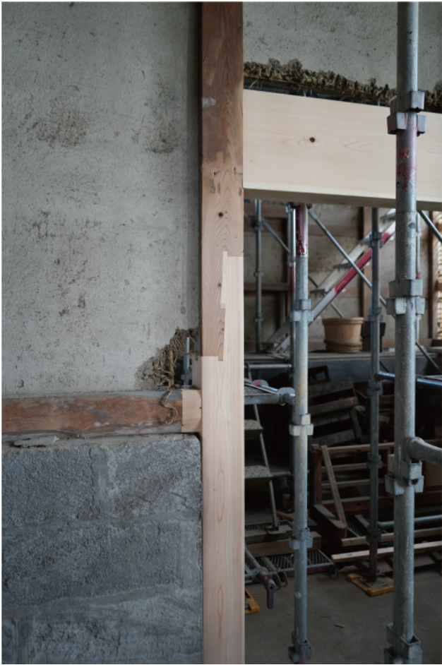
新規開口部周りの軸組補強
