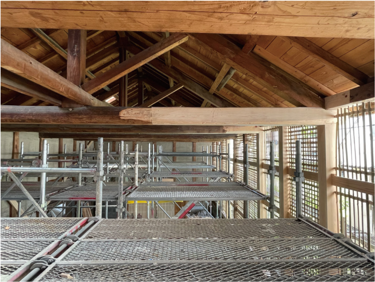
トラス下弦梁の入れ替え
