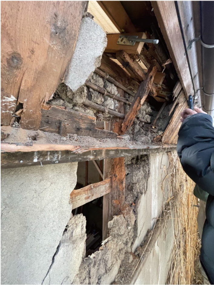
軒裏の腐朽
