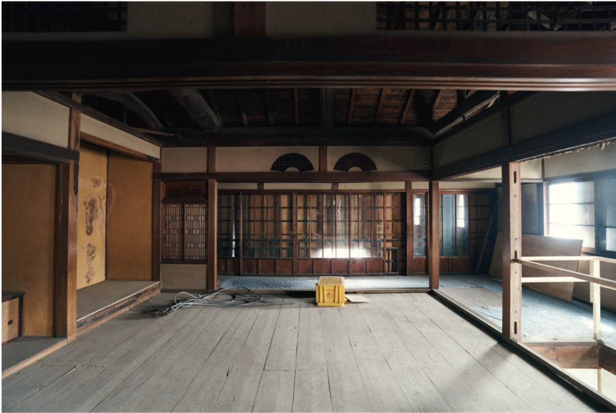
母屋 2F 和室 床、天井の取外し
