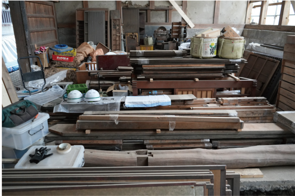
生かし取り部材を蔵に一時保管
