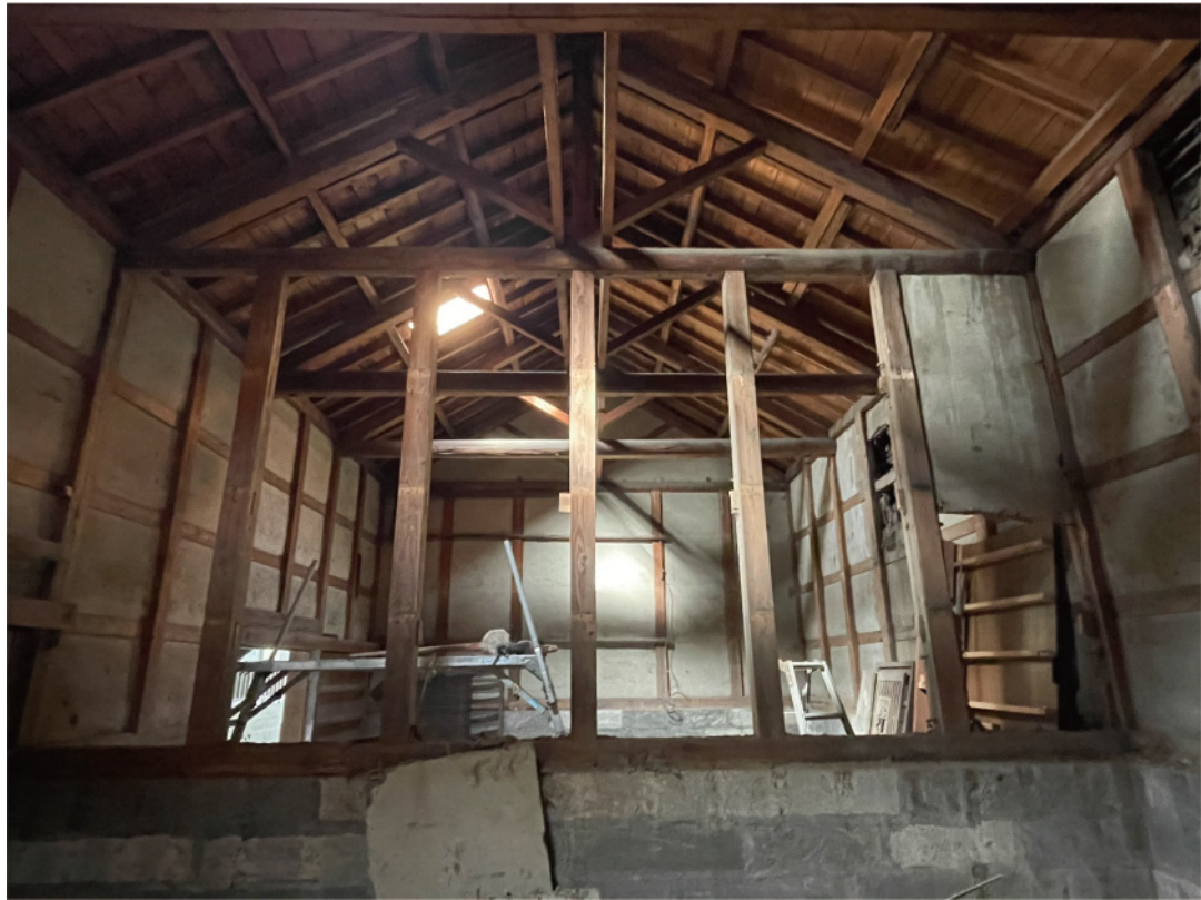
蔵 庫室間の間仕切り壁解体
