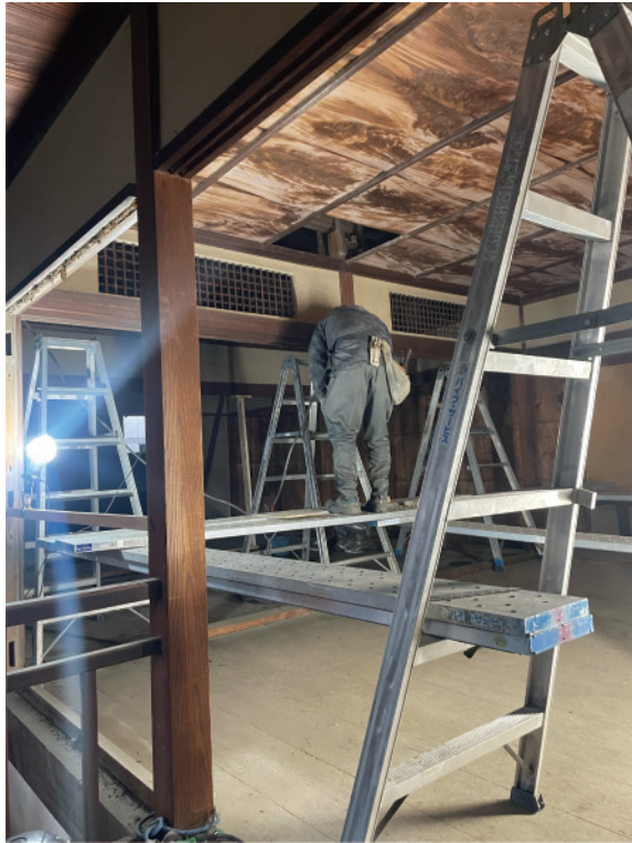
母屋 1F 和室 天井取外し
