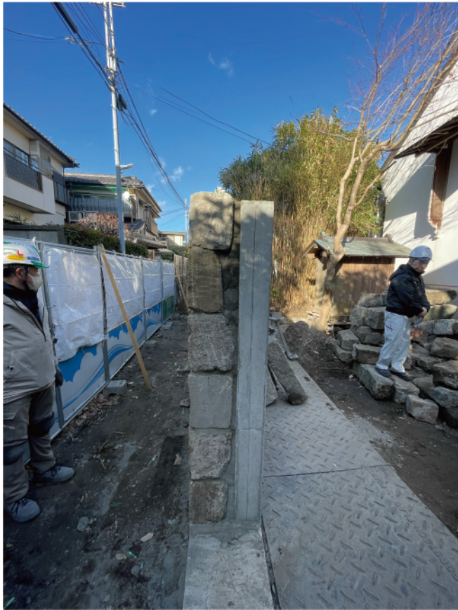
西側塀 補強完了
