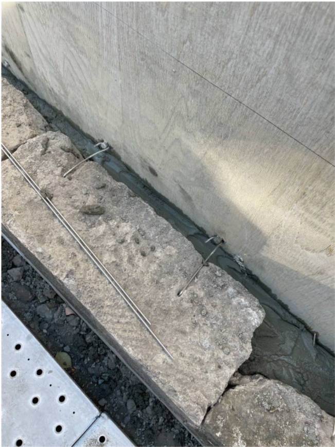
西側塀 鎌倉石積み直し、アンカー補強
