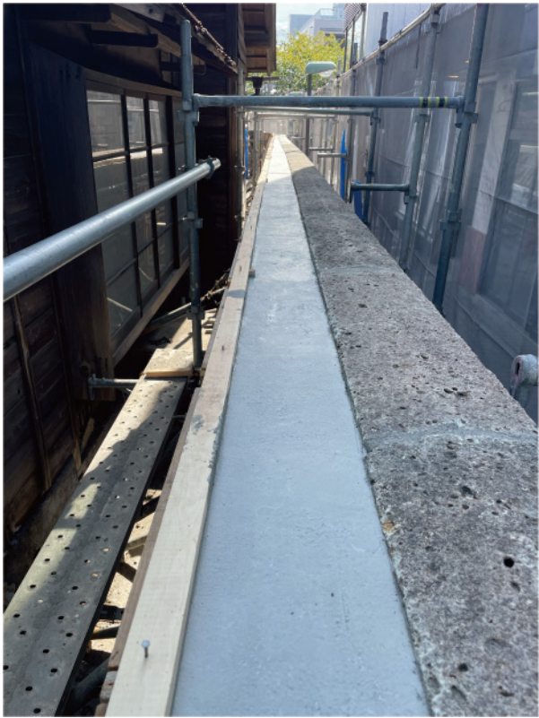
南側塀 RC 補強
