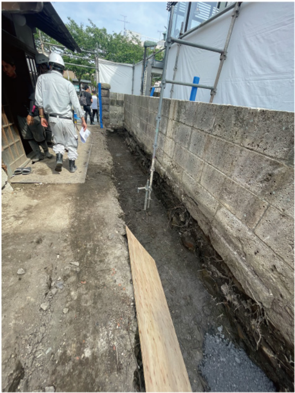
南側塀 大谷石塀内側の根切り
