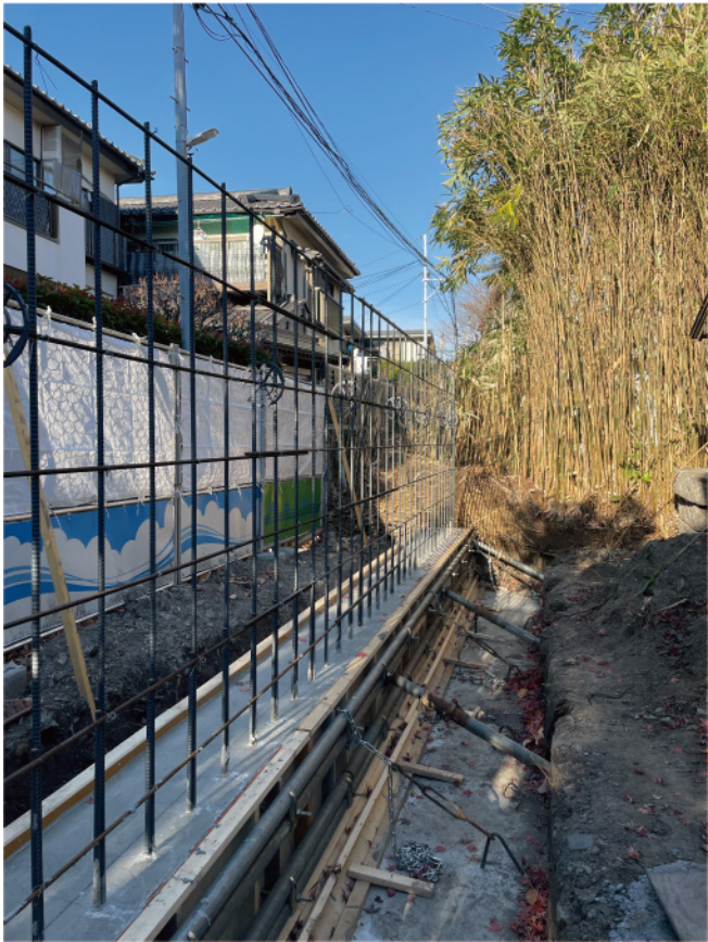
西側塀 補強 RC 塀施工
