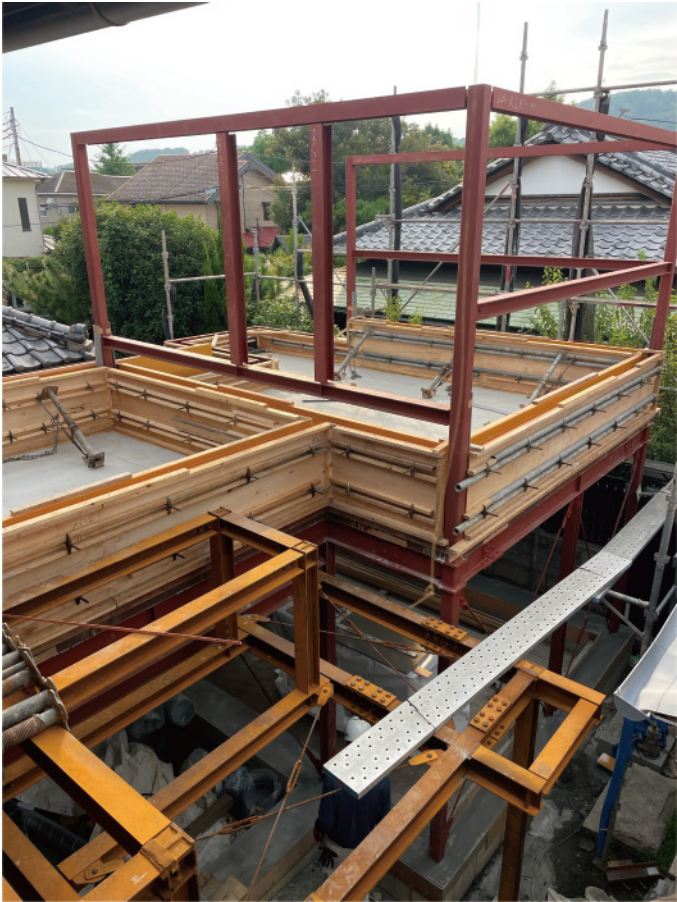
屋根スラブ打設
