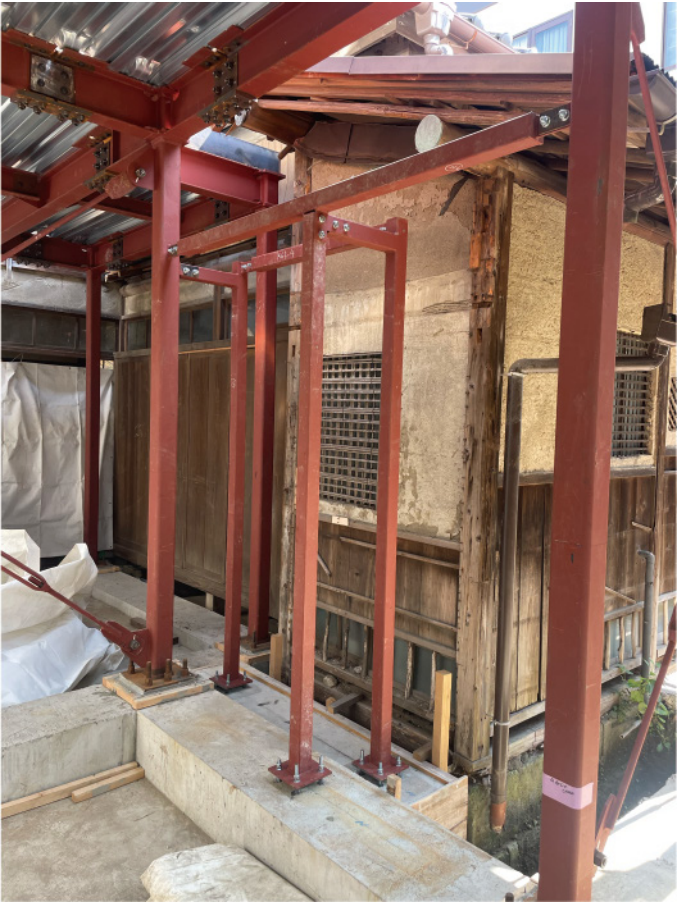
廊下接続部の鉄骨
