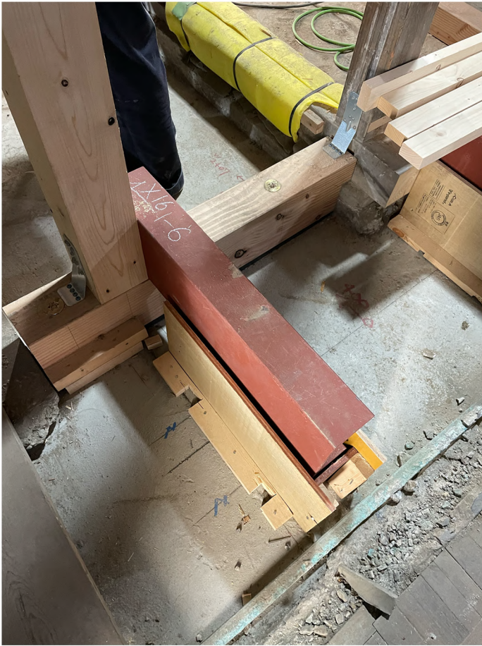
施工写真 耐震補強02
