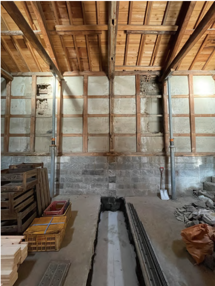
蔵 間仕切り撤去箇所へ基礎の新設
