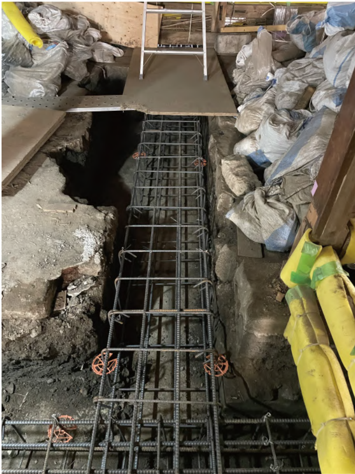
母屋 新設基礎
