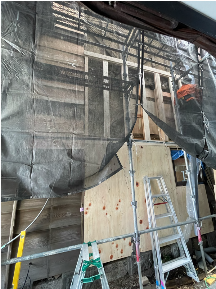
施工写真 耐震補強03
