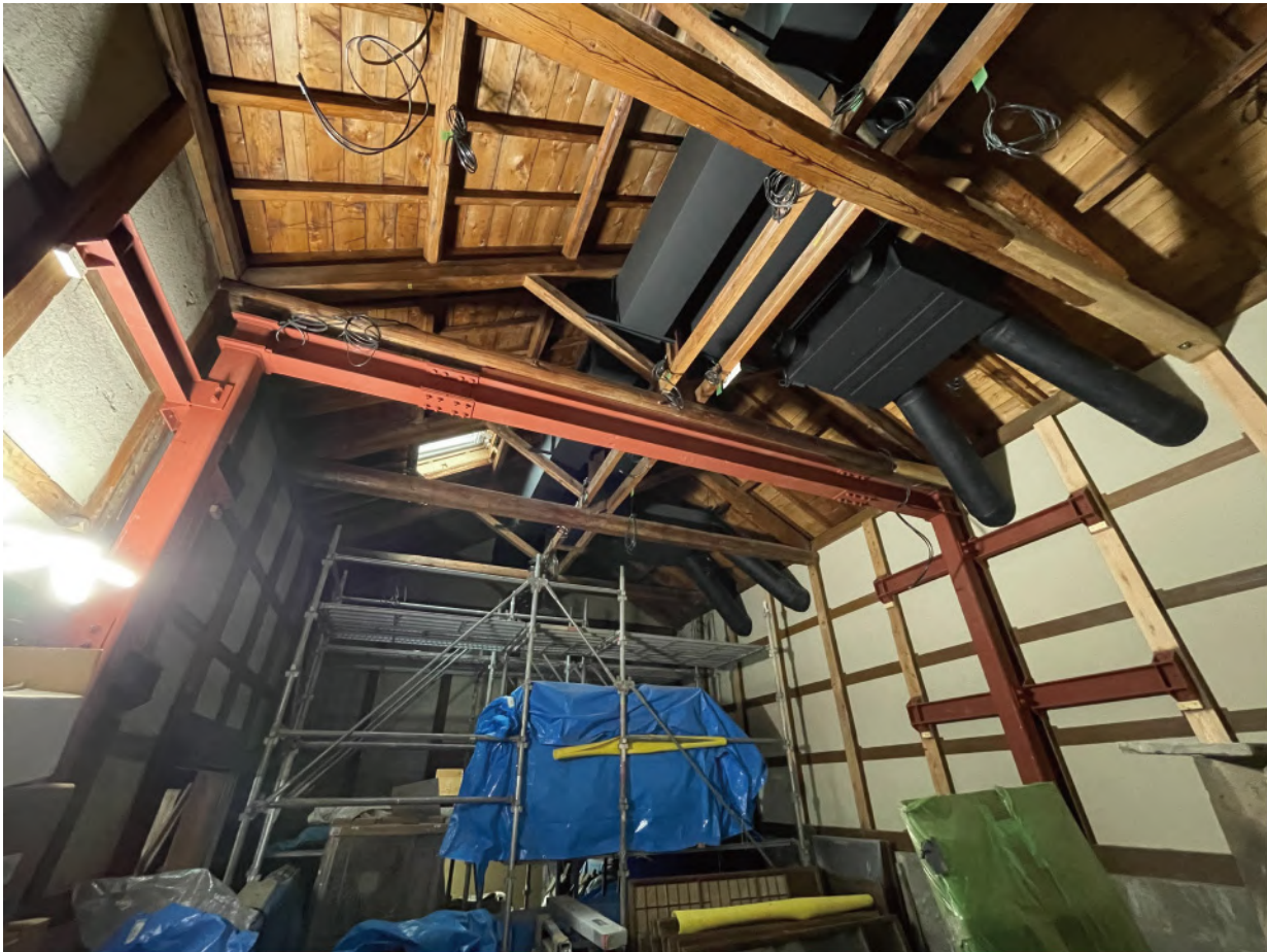
蔵 鉄骨フレーム補強
