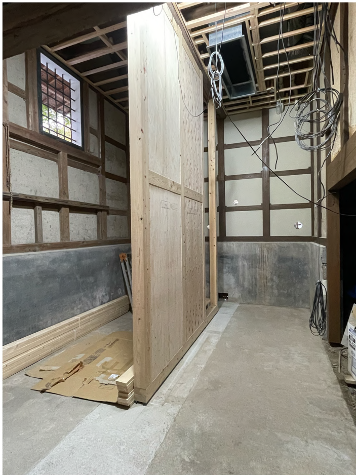
施工写真 耐震補強04
