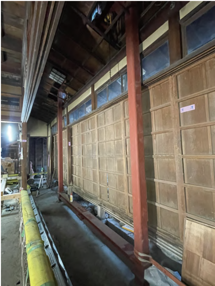
母屋 鉄骨フレーム補強
