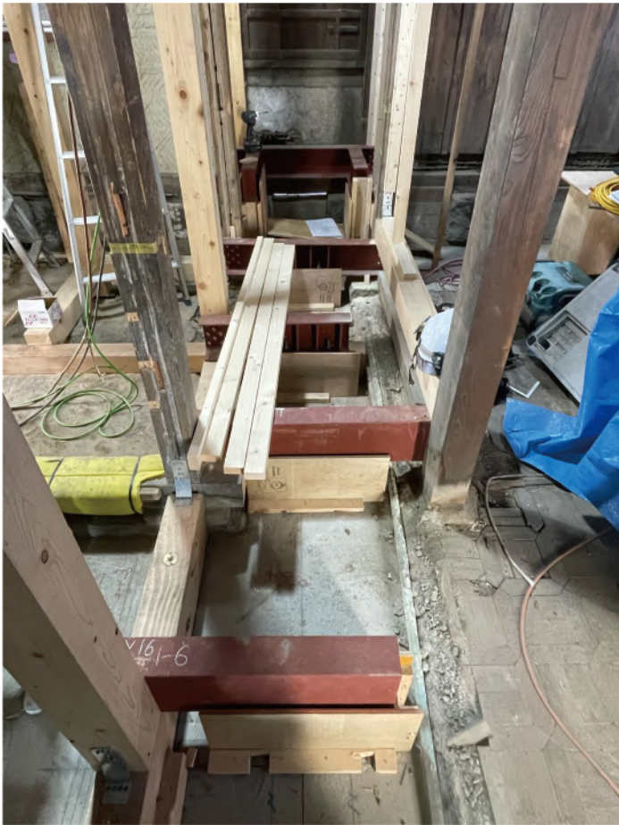
母屋 柱脚と基礎の緊結
