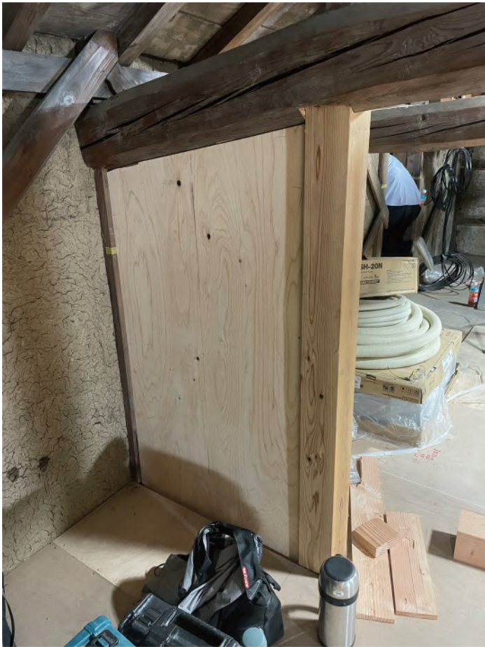
母屋 構造用合板の耐力壁
