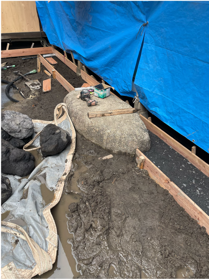
施工写真 庭・外構01
